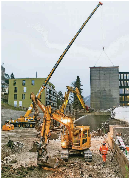
Die Turnhalle wird vom 100-Tonnen-Bagger (im Hintergrund) abgerissen. Um die umliegenden Gebäude zu schützen, hält der Kranwagen den Abbruchvorhang in die Luft.
