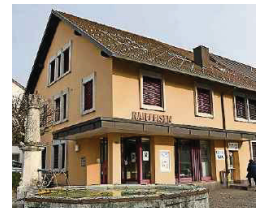
Die Filiale der Raiffeisenbank Birmenstorf wird umgebaut. AWA
